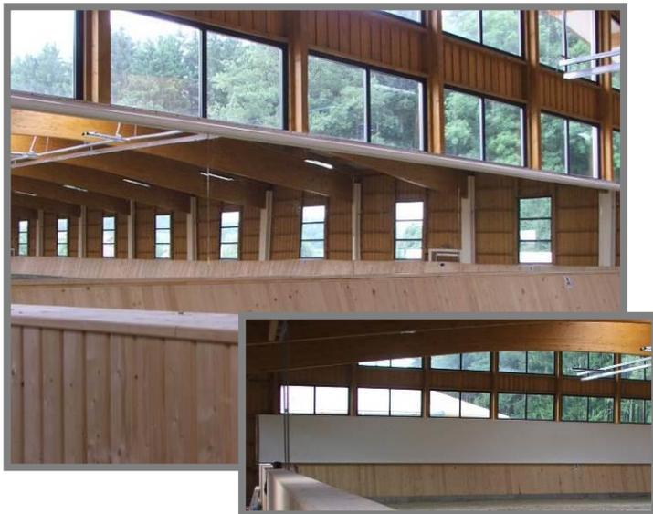
Die hochwertigen Reithallen- und Reitplatzspiegel sind entweder in einem Holzrahmen oder in einem Alurahmen eingefasst und mit einer doppelten Isolierung ausgestattet. Die Schicht aus Polypropylen auf der Rückseite des Spiegels wird im Industrieverfahren aufgebracht. Bei plötzlichem Bruch bleiben die Glasscherben an der Kunststoffschicht haften. Dadurch ist die Sicherheit für Pferd und Reiter garantiert.
